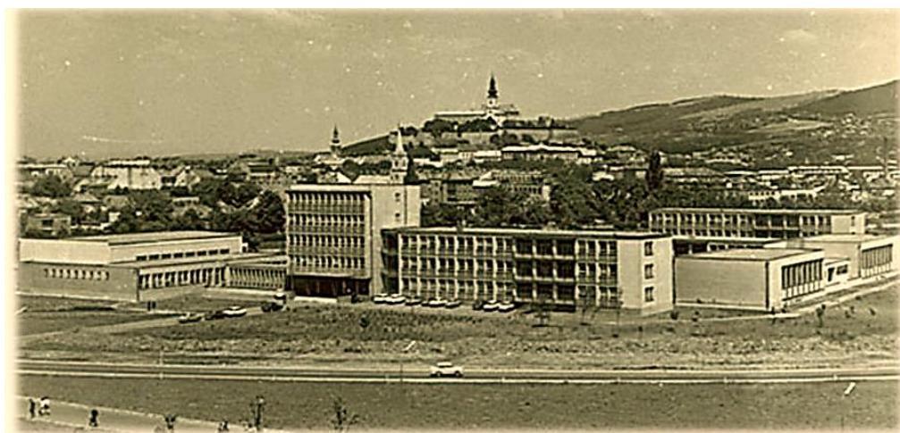
Obr. 1. Historická budova hlavnej budovy súčasnej UKF v Nitre, bez pavilónu S a nadstavby
